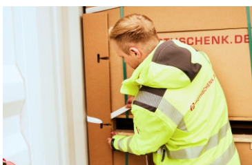
4. Gurtband durch die Ausfräsungen des Kantenschutzwinkels fädeln
