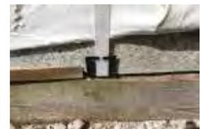
Einsatz mit Kantenschutzwinkel
